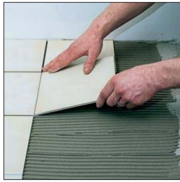
wyklejanie na elektrycznym ogrzewaniu podłogowym
