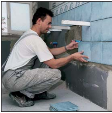
wyklejanie na płytach nośnych z twardej pianki
