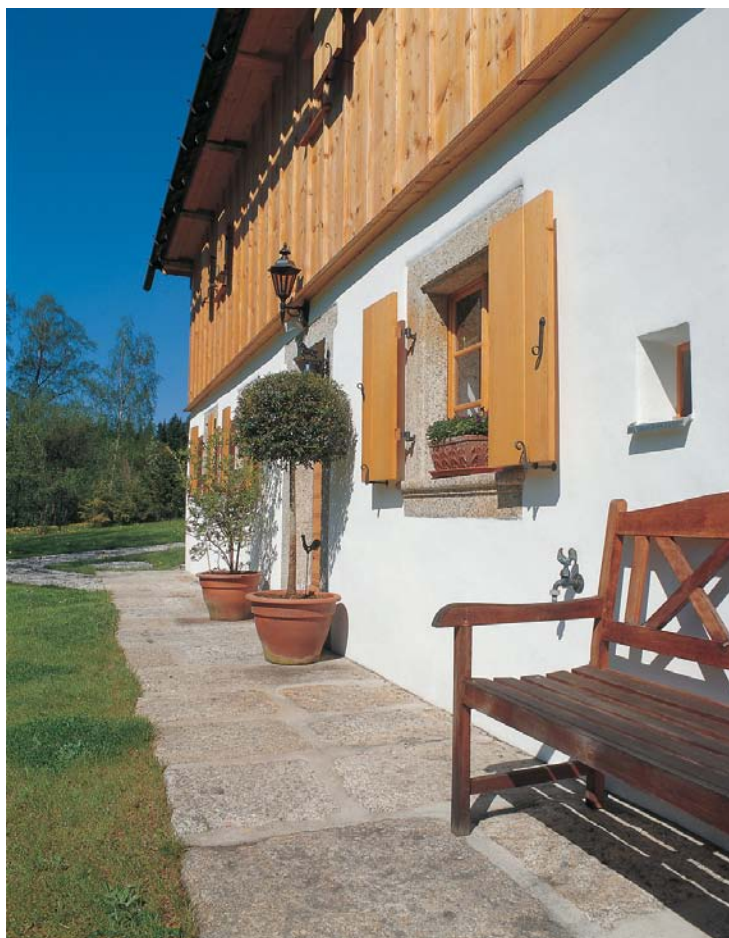
Obudowa cokołu w domu przerobionym ze stajni w Sickersreuth.
