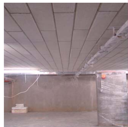
Ocieplenie stropu garażowego w budynku apartamentowym w Poznaniu.
