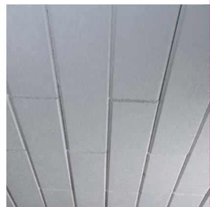
Wygląd ocieplonego stropu.
