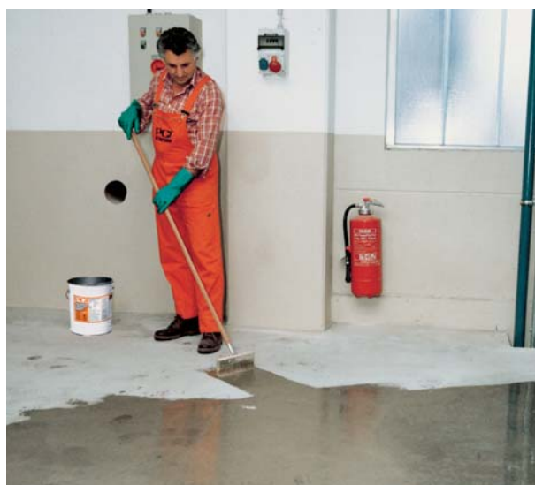
Impregnowanie jastrychu cementowego za pomocą PCI-Apogrund w celu uniemożliwienia osypywania się oraz w celu podwyższenia odporności na ścieranie.
