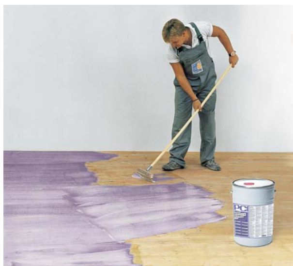
PCI Gisogrund 404 zapewnia trwałą i pewną przyczepność okładzin, mas wyrównujących i niwelujących na poszczególnych podłożach.
