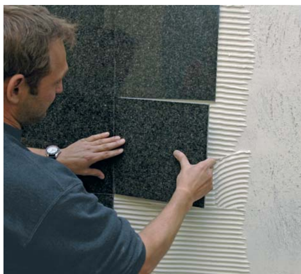
Klejenie na ścianie płyt z obrobionego kamienia naturalnego przy użyciu PCI Carralight.
