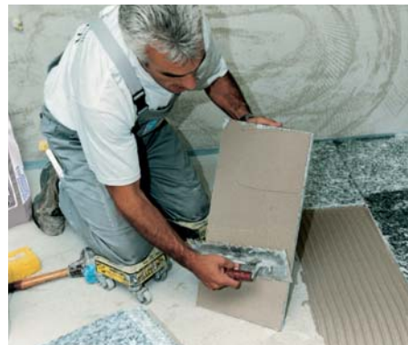
W celu układania bez pustek powietrznych należy nałożyć warstwę zaprawy na spodnią stronę płytek.
