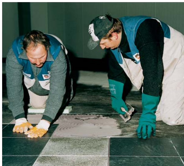
Przy użyciu PCI Carrament można w pewny sposób układać okładziny z obrobionego kamienia naturalnego na zaprawie średniowarstwowej
