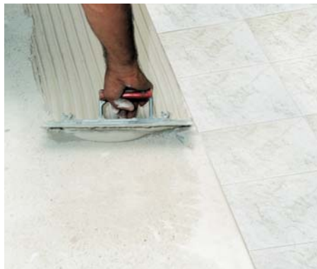
PCI Carrament jest plastyczną, łatwo formowalną zaprawą średniowarstwową i daje się łatwo nakładać.
