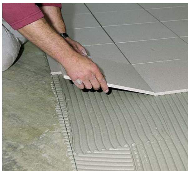
PCI Nanoflott można wykorzystywać zarówno jako zaprawę płynnowarstwową, jak i zwykłą zaprawę cienkowarstwową.
