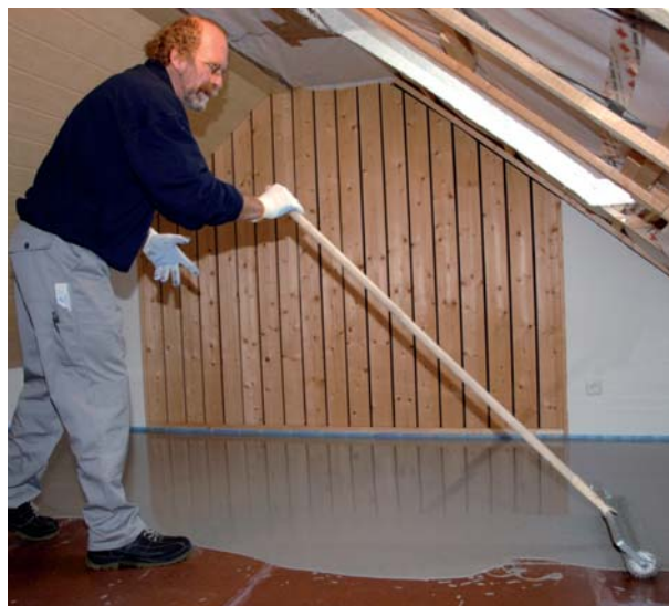
PCI Nanosilent umożliwia wyrównywanie podłoży w jednej czynności roboczej w sposób zapewniający wygłuszenie odgłosu kroków oraz oddylatowanie.
