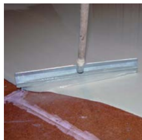
...rozprowadzić odpowiednią raklą na wymaganą grubość warstwy...
