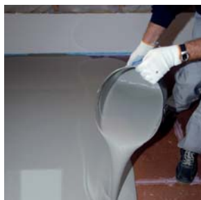
PCI Nanosilent wystarczy wylać na podłoże...
