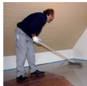
...i odpowietrzyć za pomocą walca kolczastego.
