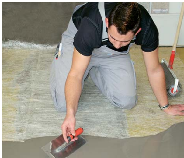
Na rozłożonej macie wzmacniającej z włókna szklanego PCI Armiermatte GFM wylewa się odpowiednią podłogową masę wyrównawczą PCI i rozprowadza ją szpachelką (na minimalną grubość 5 mm).
