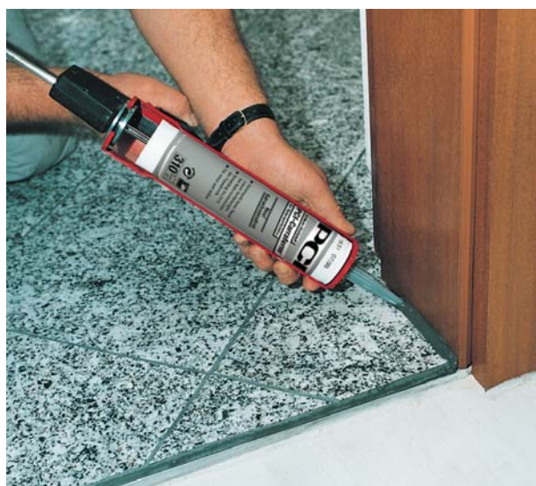
Przy zastosowaniu PCI Carraferm nie powstają żadne przebarwienia w strefie krawędziowej obrobionego kamienia naturalnego
