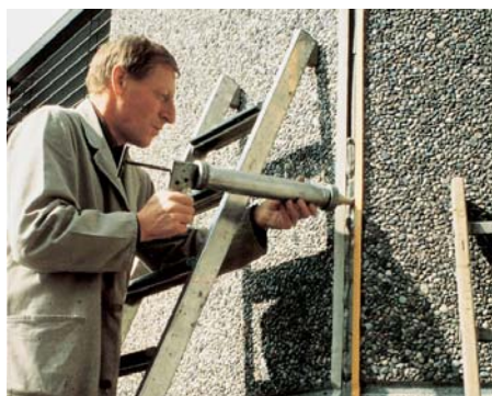
Uszczelnienie szczeliny dylatacyjnej na powierzchni płyt ze strukturą betonu płukanego.
