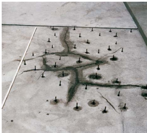
Zamykanie rys i sklejanie odspojonych jastrychów za pomocą PCI Apogel F.
