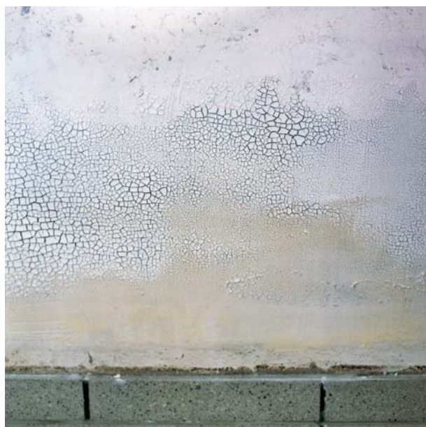
Naniesiony pastowaty PCI Entöler wiąże rozpuszczone zanieczyszczenia i zasycha w postaci skorupy łatwej do usunięcia.
