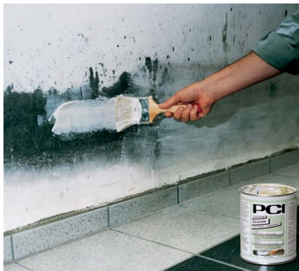
Nanoszenie pasty PCI Entöler na ścianę zaolejoną wskutek szkód podziwowych.
