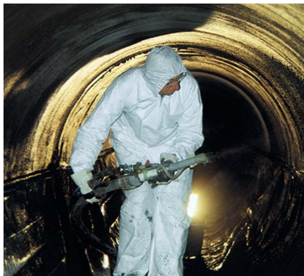
Nanoszenie zaprawy PCI-Kanament metodą natryskową.
