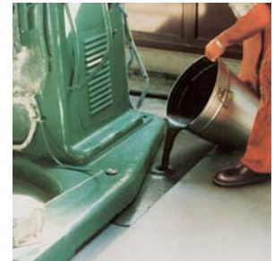
PCI Vergussmörtel tworzy połączenia bez szwu, bez rys i bez pustych przestrzeni. Zapewnia spokojną i precyzyjną pracę maszyn i mniejsze ich zużycie.
