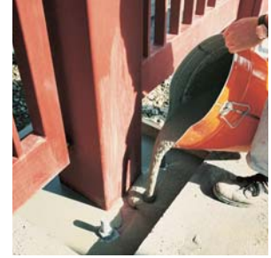
PCI Vergussmörtel jest łatwo rozptywny i bez problemu wypełnia poziome przestrzenie.
