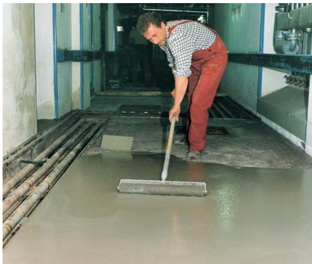
PCI Zemtec 1K naniesiony na posadzkę, po uprzednim stwardnieniu środka gruntującego, rozprowadzać rakiem i odpowietrzać za pomocą wałka kolczastego.
