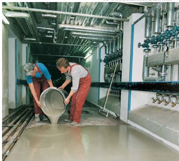
Pełnopowierzchniowe wyrównanie posadzki łatwo rozplýwnym PCI Zemtec 1K do bezpośredniego użytkowania.
