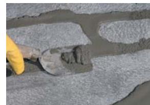
Nadmiar ściągnąć twardą pacą gumową lub szpachlą.
