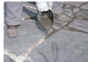
Odpowiednim naczyniem do wylewania wprowadzić PCI Pavifix CEM w przygotowane spoiny.
