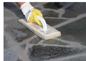
W ciągu godziny doczyścić wykładzinę płytkową packą z gąbką.
