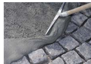
W metodzie szlamowania PCI Pavifix CEM można łatwo wprowadzić w spoiny za pomocą pacy gumowej.
