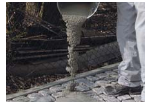
Nanoszenie PCI Pavifix CEM na przeznaczoną do spoinowania powierzchnię.
