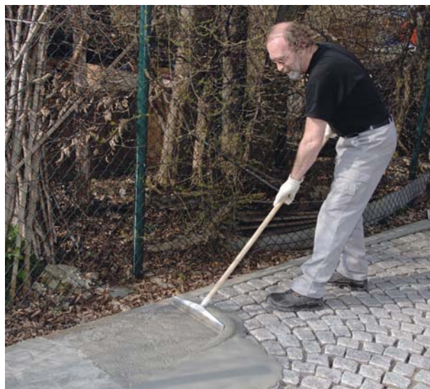
W przypadku metody szlamowania PCI Pavifix CEM można łatwo wprowadzić w spoiny za pomocą pacy gumowej.
