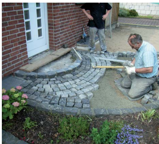
Układanie drobnowymiarowej kostki brukowej na zaprawie PCI Pavifix DM
