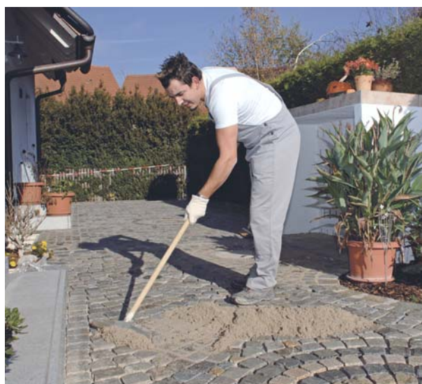
Dwuskładnikowa zaprawa do spoinowania bruku PCI Pavifix PU jest wodoprzepuszczalna i zapobiega tym samym całkowitemu zamknięciu powierzchni. Woda deszczowa może szybko spłynąć do podłoża.
